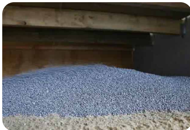
Bodemisolatie met korrels
